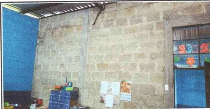
Foto 5: Hay paredes de aulas del modulo 1 que no se han culminado terminar de pintar y las paredes pintadas ya muestran desgaste
