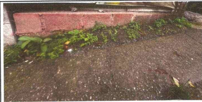
Foto 3: Muro perimetral Modulo 1. Solo se logro en la parte izquierda levantar la zapata y dos hiladas de block lo cual deja vulnerable el establecimiento, ante cualquier acto de delincuencia.
